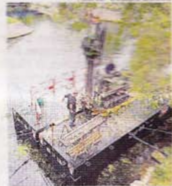
La plateforme de forage.
