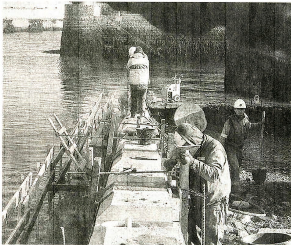
Les techniciens s'affairent sur la poutre qui doit être scellée pour être totalement solidaire de la cale.
